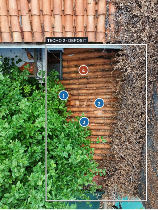
Con los números de cada sección Los números en la foto corresponden a las secciones. Azul = gotera.
